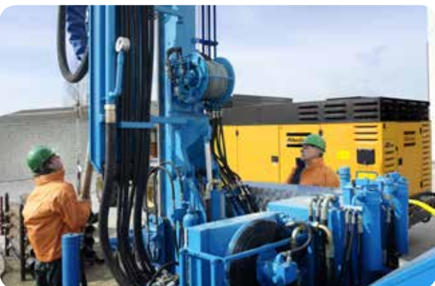
Geotermisk borrhning
